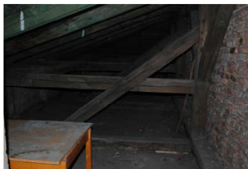
FOT 6. / WIĘŻBA DACHOWA /
