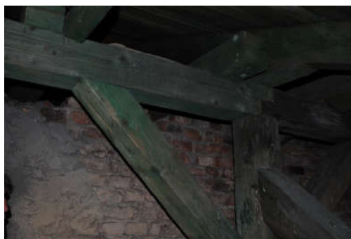
FOT 5. / WIĘŻBA DACHOWA /
