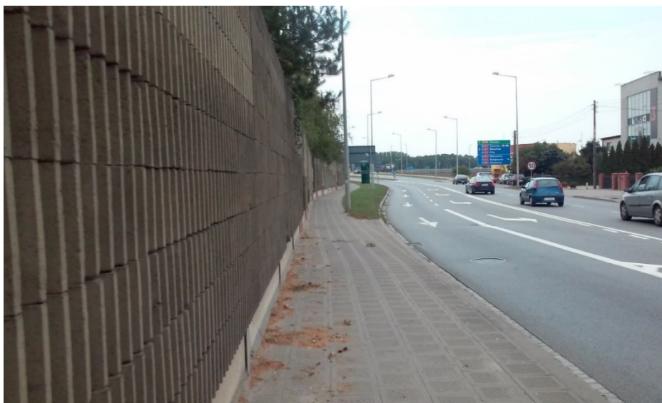
Rysunek 14. Zastosowanie ekranu akustycznego z paneli betonowych wraz z ograniczeniem prędkości (znak drogowy). Źródło: zdjęcie własne.
