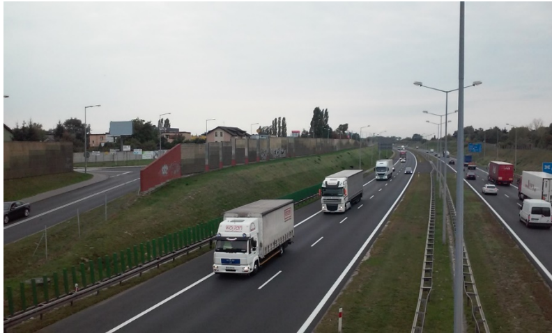
Rysunek 15. Zastosowanie ekranu akustycznego wraz z wałem ziemnym. Źródło: zdjęcie własne.
