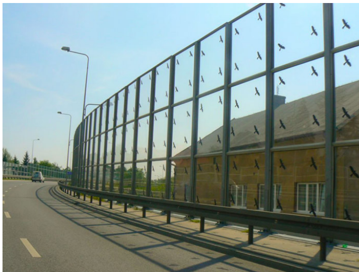
Rysunek 17. Zastosowanie przezroczystego ekranu z akrylu. (Źródło: Internet http://ro.com.pl/ogranicza-liczbe-ekranow-dzwiekochlonnych-na-drogach/01151290 )
