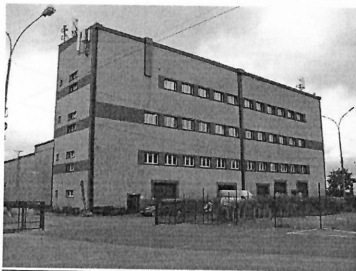
Zał. nr 1: Widok ogólny instalacji radiokomunikacyjnej.
