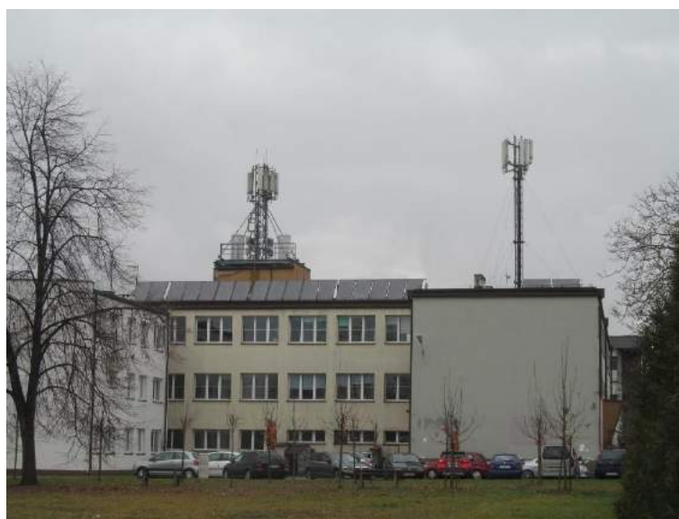
Zał. nr 1: Widok ogólny instalacji radiokomunikacyjnej.
