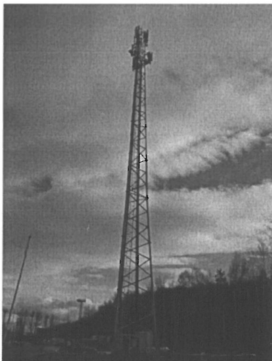
Zał. nr 1: Widok ogólny instalacji radiokomunikacyjnej.
