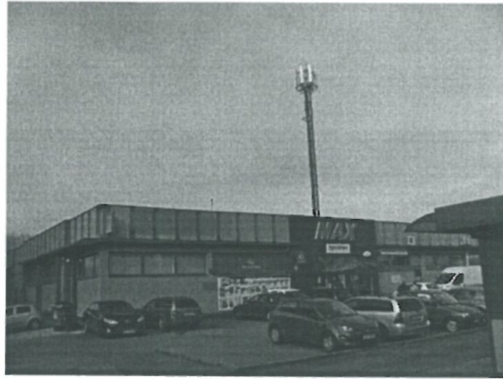
Zal. nr 1: Widok ogólny instalacji radiokomunikacyjnej.
