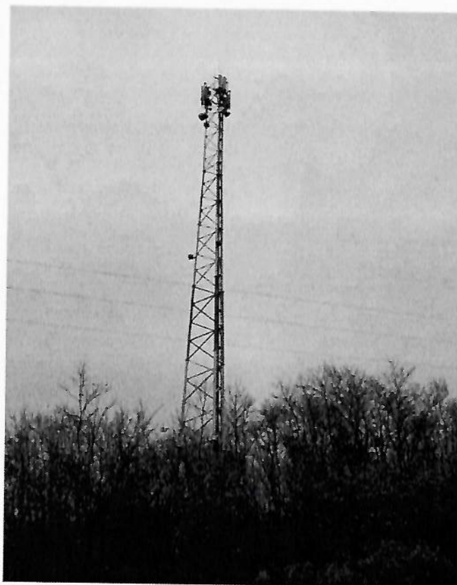
Zof. nr 1: Widok ogólny instalacji radiokomunikacyjnej.
